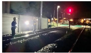
踏切設備点検
